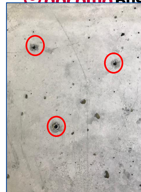
③下穴をあけプラグを埋め込む ※○印3か所
