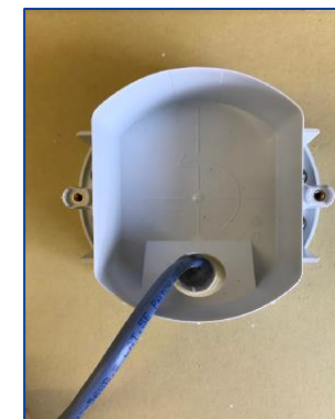
④ベースを設置面に固定し、LANケーブルを通線口から通す
