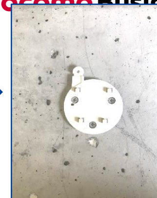
⑤設置面に取付板を固定する ※ネジを締める際は手動のドライバーもしくは低速回転の電動ドライバーをご使用ください。
