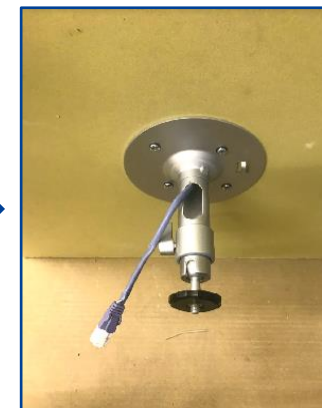
⑧フィクサーを固定しLAN(UTP)ケー ブルを通す
