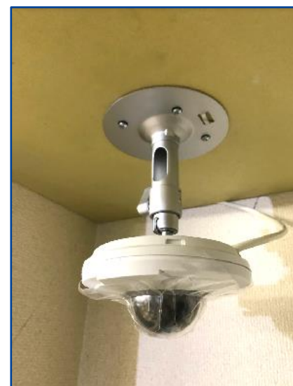
⑥カメラを設置する ※設置後は必ずフィルムを剥がしてください。
