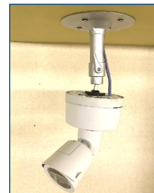
⑧フィクサーにカメラを取り付ける。
