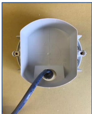
⑥ベースを設置面に固定し、LANケーブルを通線口から通す
