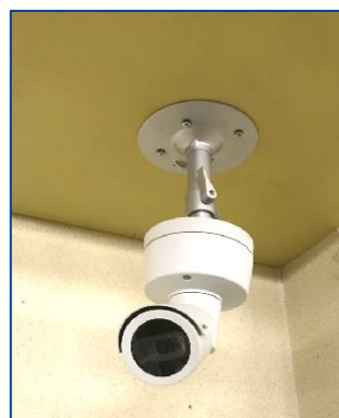
⑩完了 ※画角調整後はT10ビスを確実に締めてください。
