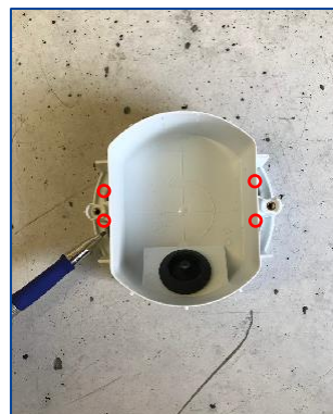
③ベースを設置面にあて墨出しをする。 ※固定穴○印4か所
