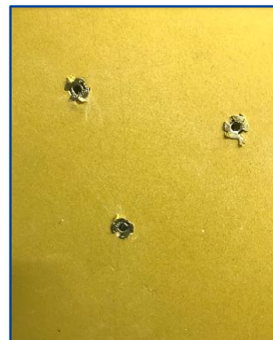
③アンカー本体を取り付ける ※ビスで固定する場合は下穴は不要です。
