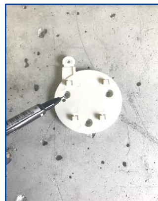
③墨出しをする ※ずれないようにシール等で仮固定するとO
