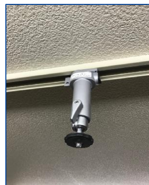
③ライティングレールにフィクサーを取り付ける
